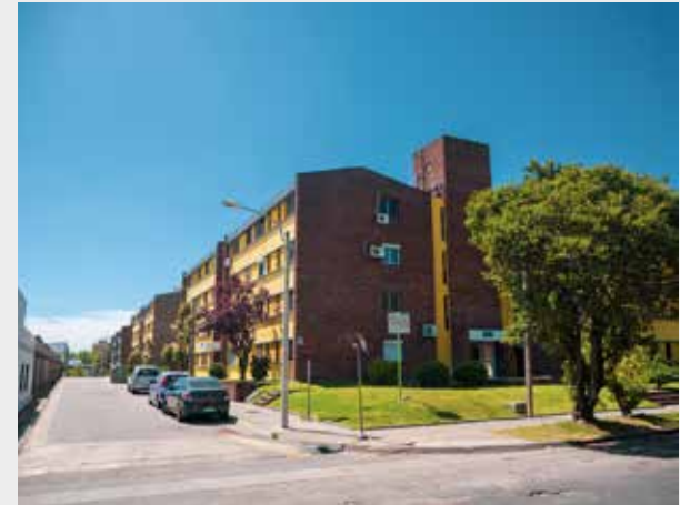
Complejo Habitacional CH99. Octubre 2020
